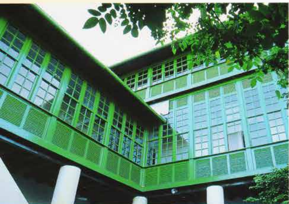
Fechamento de varanda em madeira de lei e venezianas, característica marcante dos grandes sobrados do Centro Histórico (acima). Fermeture de balcon en bois et volets, caractéristique marquante des grandes maisons du centre historique de São Luís (au-dessus).
